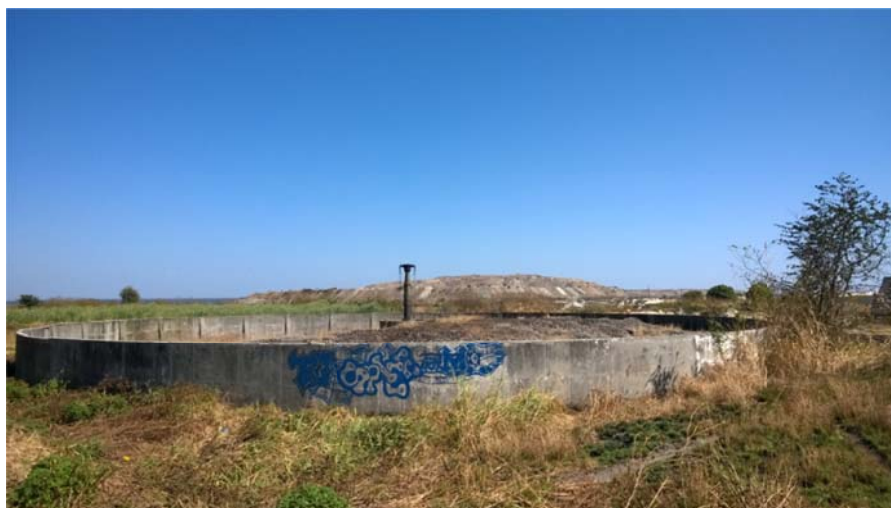
Copperbelt-Provinz – Chingola – Altes Tropfkörperbecken
